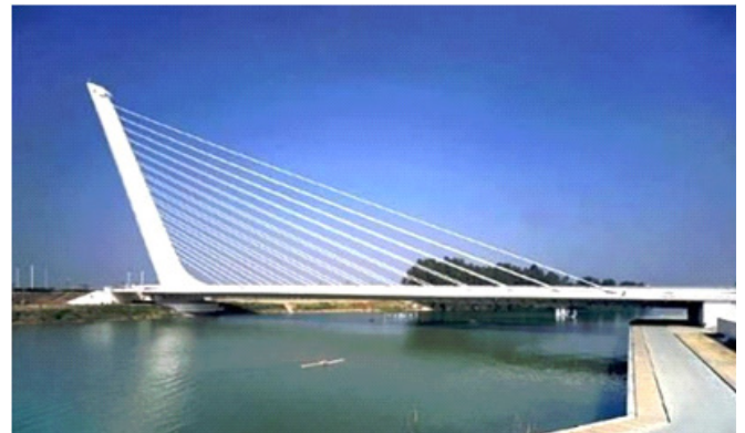
Puente atirantado , El Alamillo, Sevilla.
